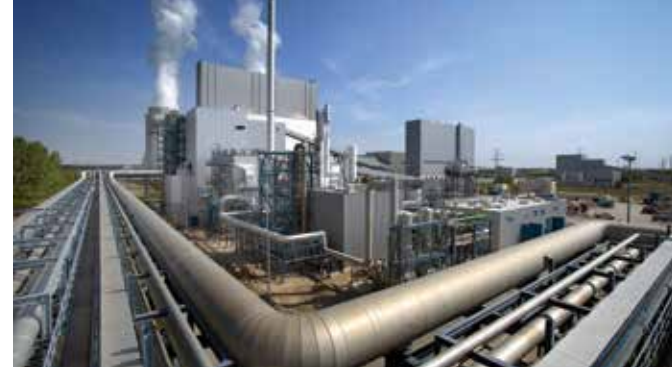
Instalaciones de I+D de Vattenfall, Schwarze Pumpe, Alemania. Fotografía por cortesía de Vattenfall AB.
