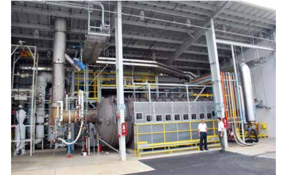
Laboratorio avanzado de combustión de energías limpias de Carburos Metalicos
